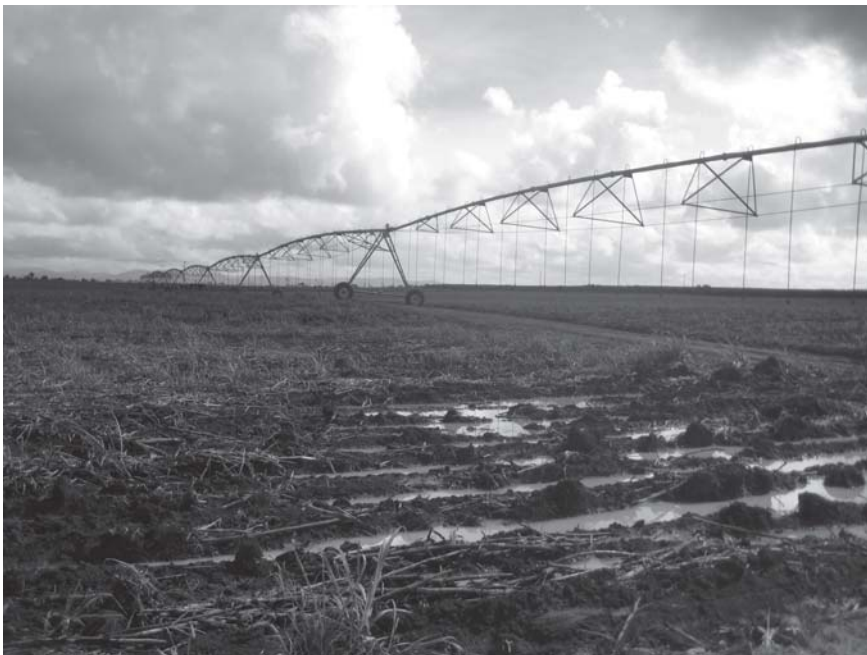
Instalación industrial de riego de campos azucareros en Alagoas, Brasil.
